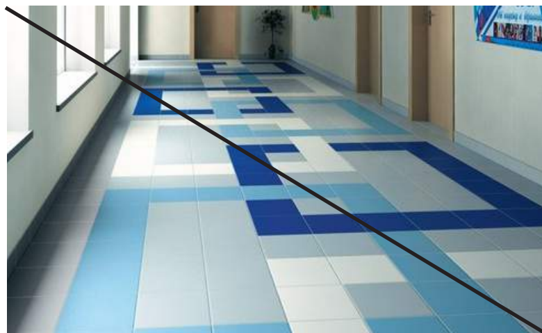
Плохо Цветные вставки из плитки
